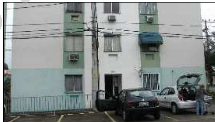
Entrada do Bloco 1
