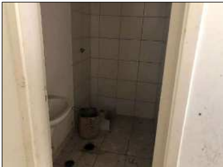
Sanitário - Apartamento Tipo
