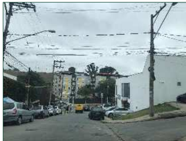
Vista do empreendimento
