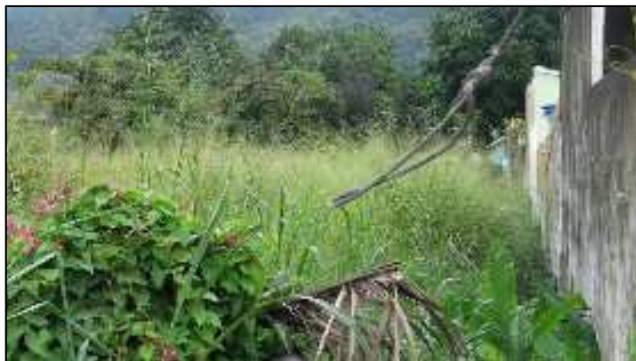
Vista interna (fundações)
