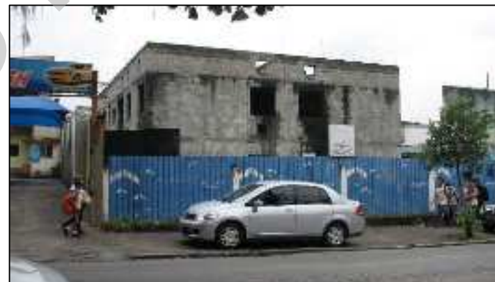
Vista frontal construção existente
