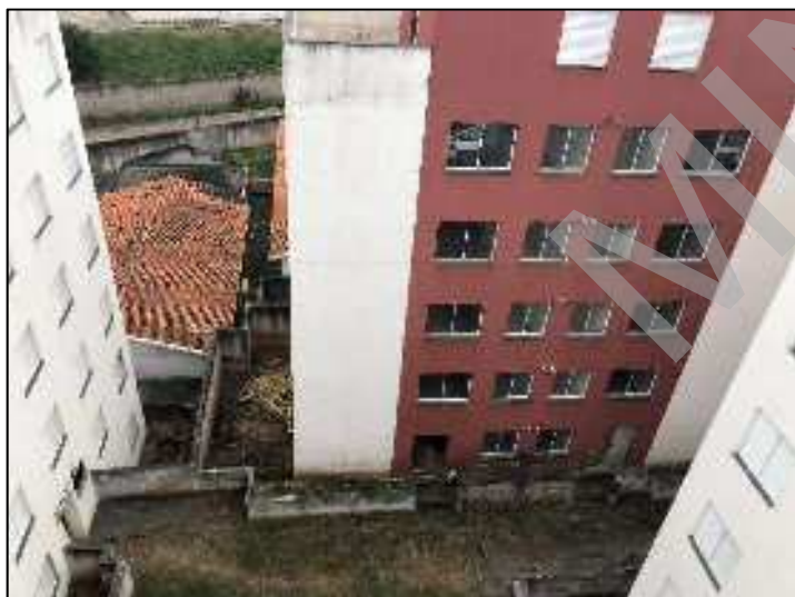
Vista da Cobertura
