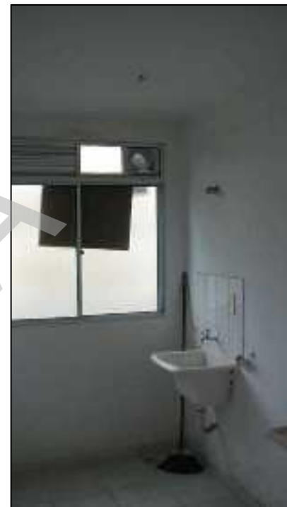
Vista interna do apartamento 411, Bloco 1
