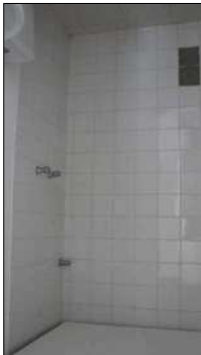
Vista interna do apartamento 411, Bloco 1
