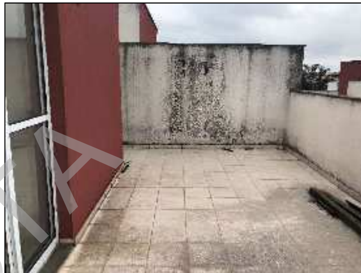
Sacada 2º Pavimento - Apartamento Cobertura
