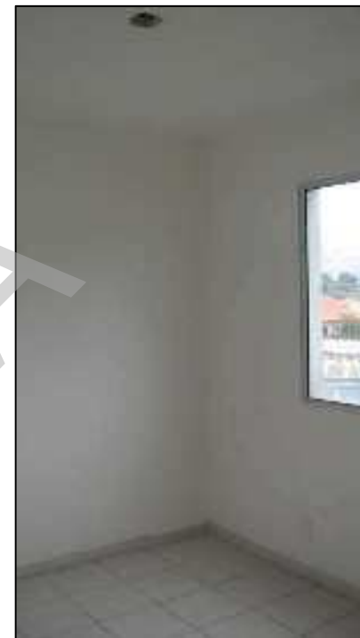
Vista interna do apartamento 411, Bloco 1
