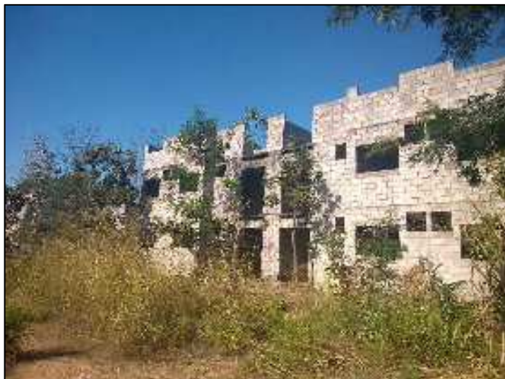
Vista do bloco
