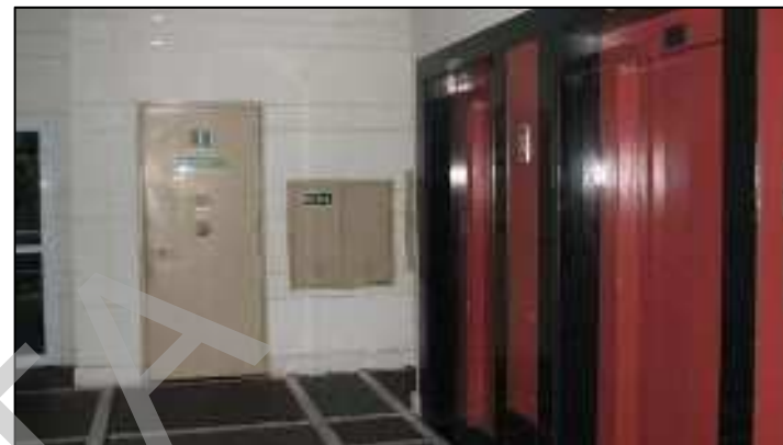
Hall de elevadores
