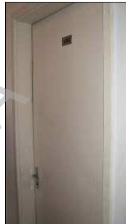
Entrada do apartamento 411, Bloco 1
