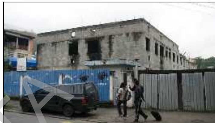
Vista frontal construção existente
