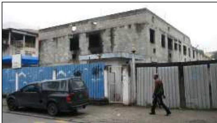
Vista frontal construção existente
