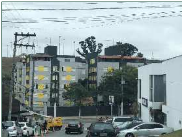
Vista fachada e entrada
