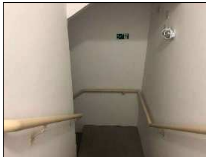
Escada de Incêndio
