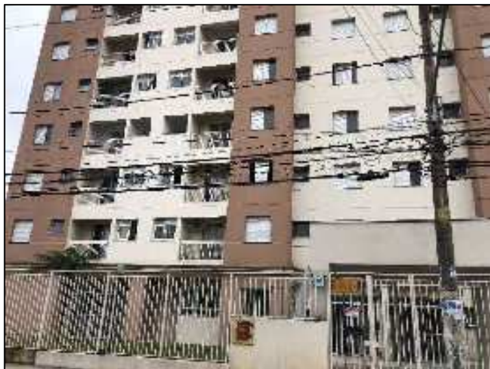
Fachada - Torre A
