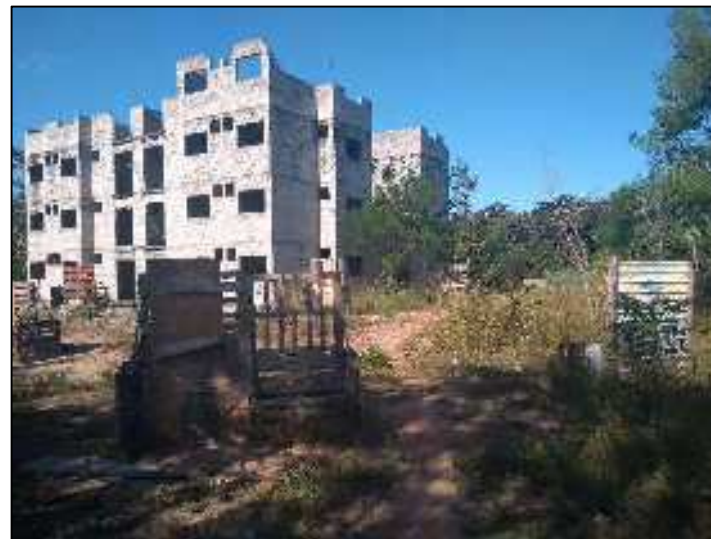
Vista do bloco
