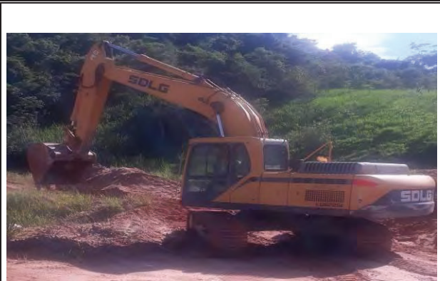
- QUATIS - ESCAVADEIRA LG 6225E -
