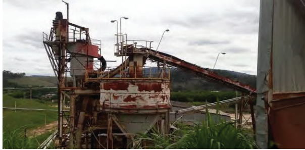
- QUATIS - SILO DE ALIMENTAÇÃO / CLASSIFICADOR / HIDROCICLONE -
