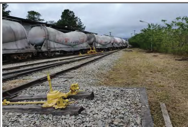
- PÁTIO FERROVIÁRIO E HOOPERS DE DESCARGA DE VAGÃO -
