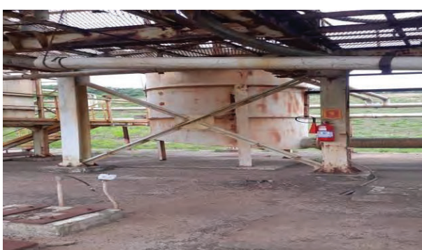
- QUATIS - CAIXA DE REJEITOS DO FINO E FERRO-
