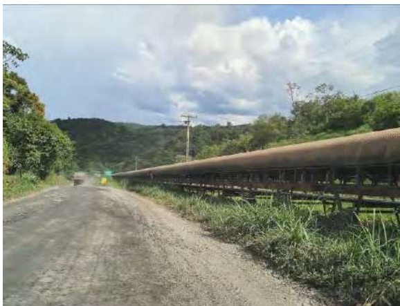
Imagens 16 e 17 – Estrada de acesso à jazida seguida da esteira de transposição do calcário e estrutura de suporte
