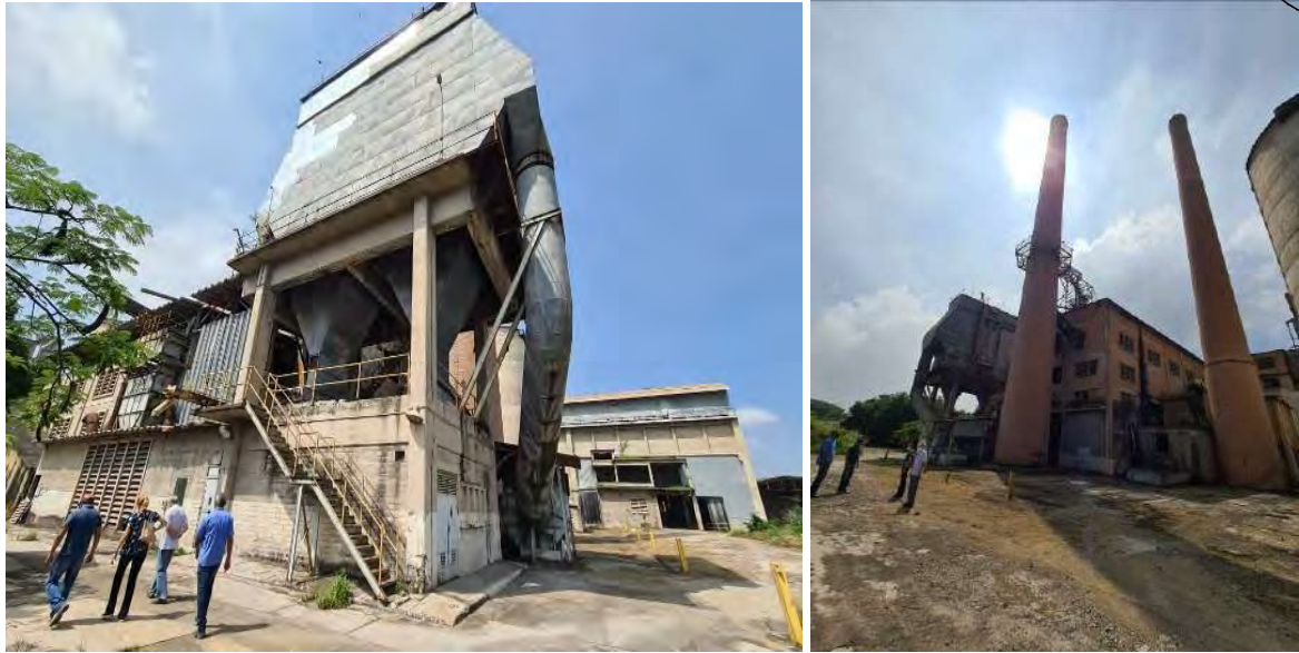
Imagens 46 e 47 – Sistema de filtros da unidade de Volta Redonda / RJ.
