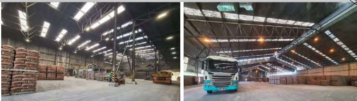
Imagens 7 e 8 – Área de ensacagem e armazenagem de cimento em saco
