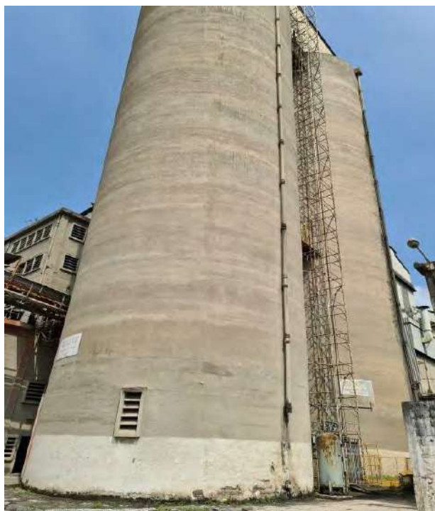
Imagens 43 a 45 – Silos de estocagem de material da unidade de Volta Redonda / RJ
