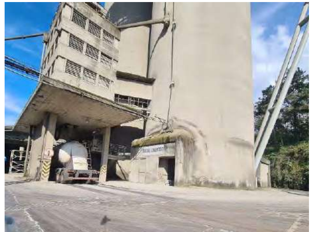
Imagens 5 e 6 – Área de armazenagem (silos) e carregamento de cimento a granel de vagões (esquerda) e caminhão (direita)
