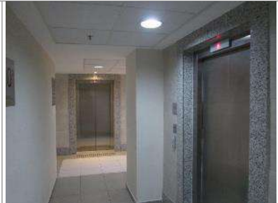
Hall de elevadores
