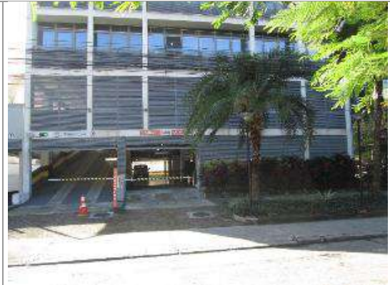
Acesso da garagem
