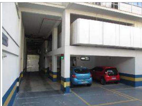
Acesso ao Estacionamento nos fundos
