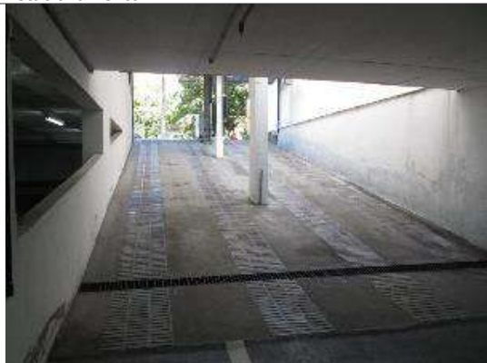
Rampas de acesso a garagem
