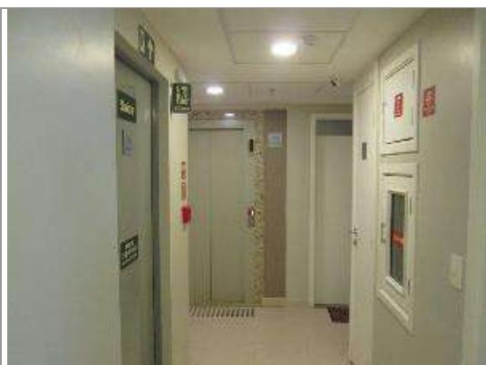
Hall de elevadores e circulação do andar
