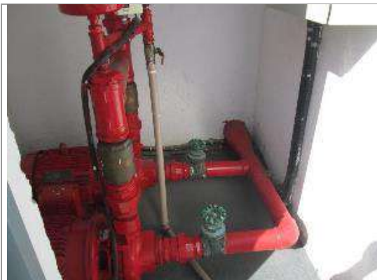
Casa de bombas de incêndio
