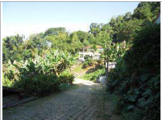
Detalhes do loteamento.
