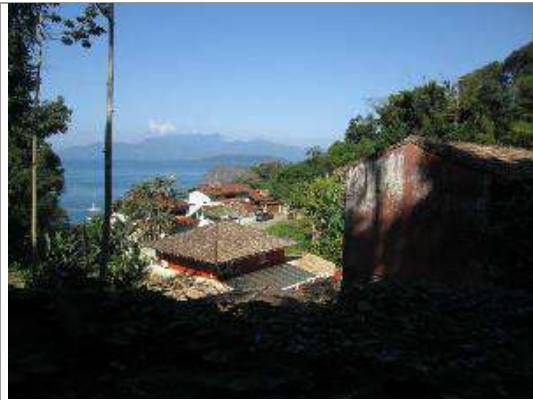
Detalhes do loteamento
