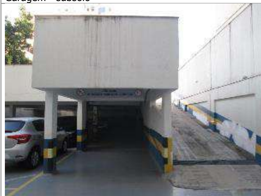
Acesso ao Estacionamento nos fundos
